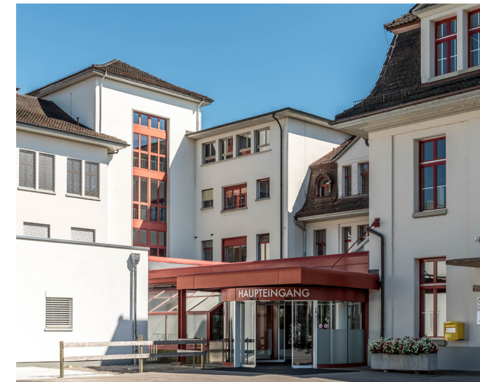
Das Spital Tiefenau setzt auf erneuerbare Energien.
